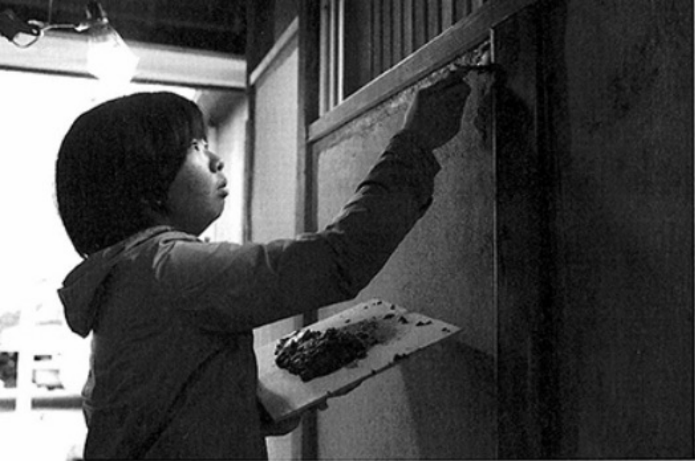
壁の四周「チリ廻り」を押さえる。現場での実践は初めてだが、週に2回通う京都市内の左官学校で技術を高めている。
